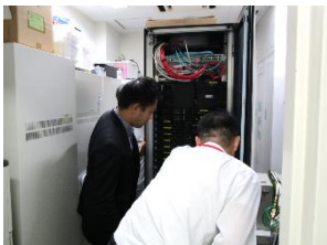
(設備・機器の点検)
